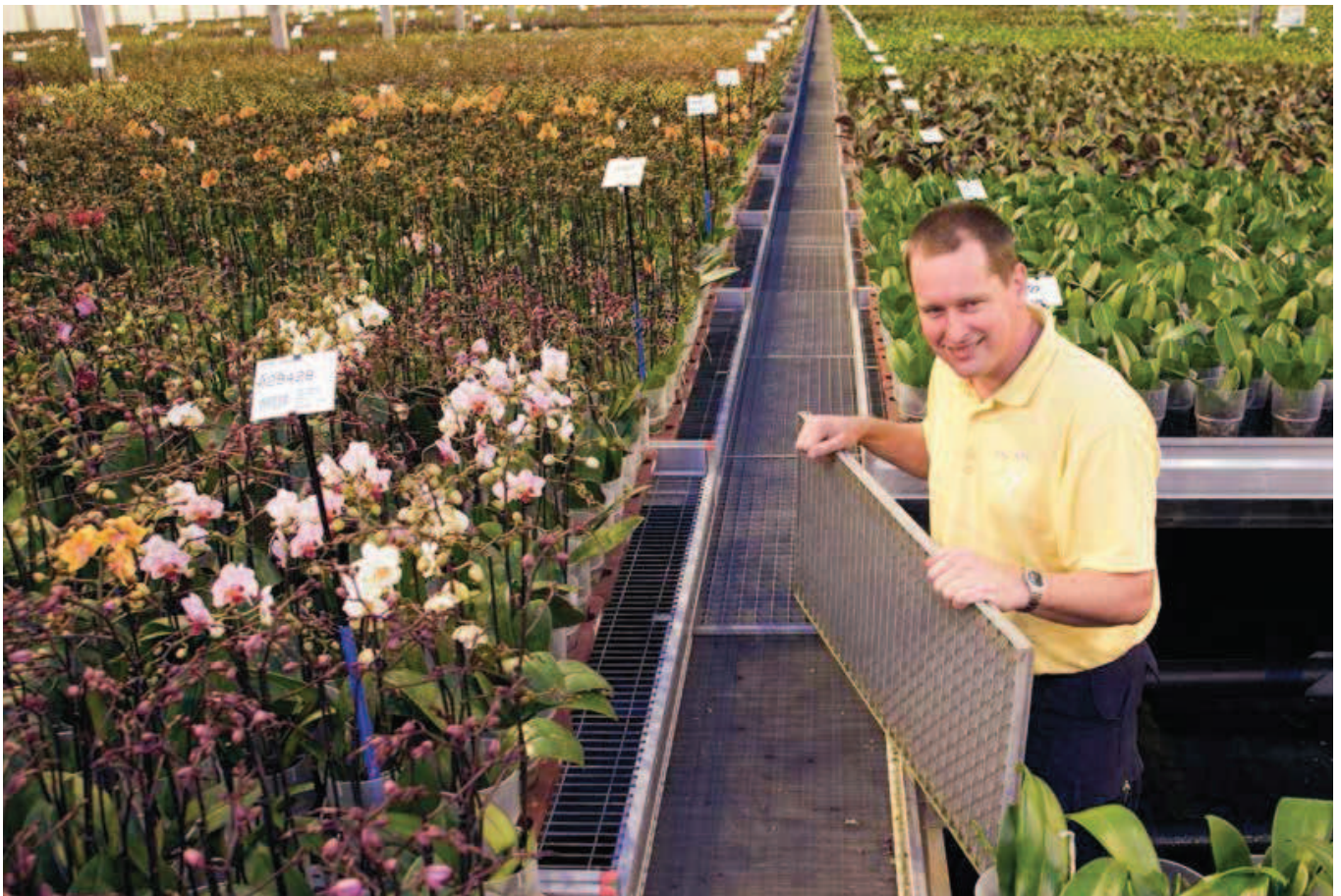
Maurice van der Hoorn gebruikt voor koeling en verwarming dezelfde convectors. "Het is één circuit."
