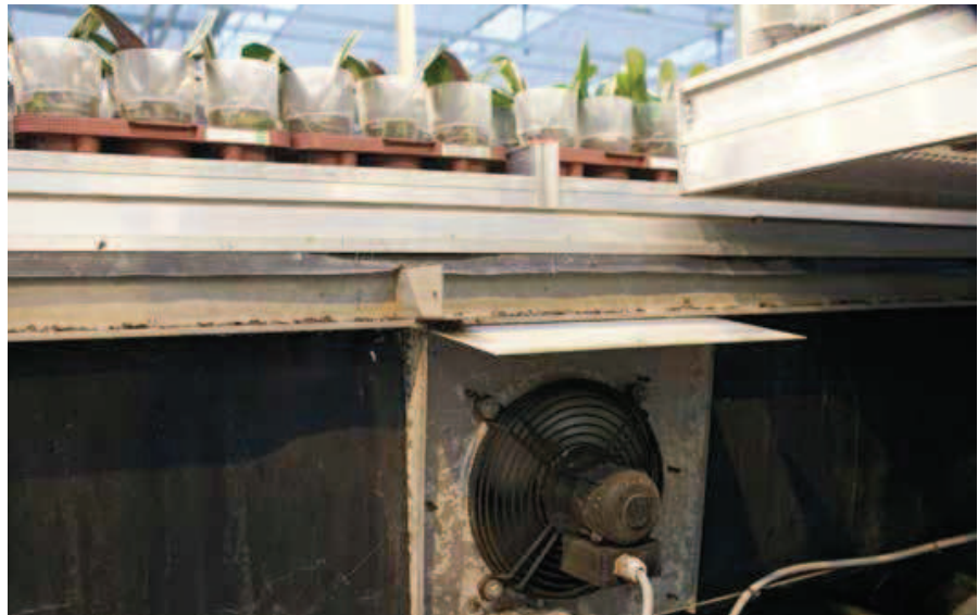
Convectors en ventilatoren liggen onder de rolcontainers. Dit is de meest directe regeling.
