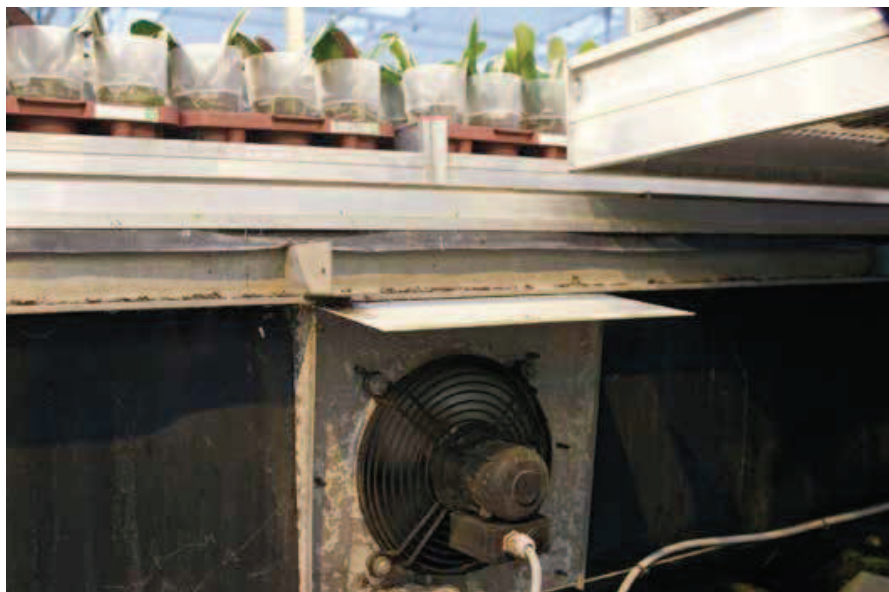
Convectors en ventilatoren liggen onder de rolcontainers. Dit is de meest directe regeling.
